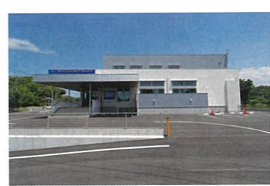
▲浸水対策のため盛り土を行っている
